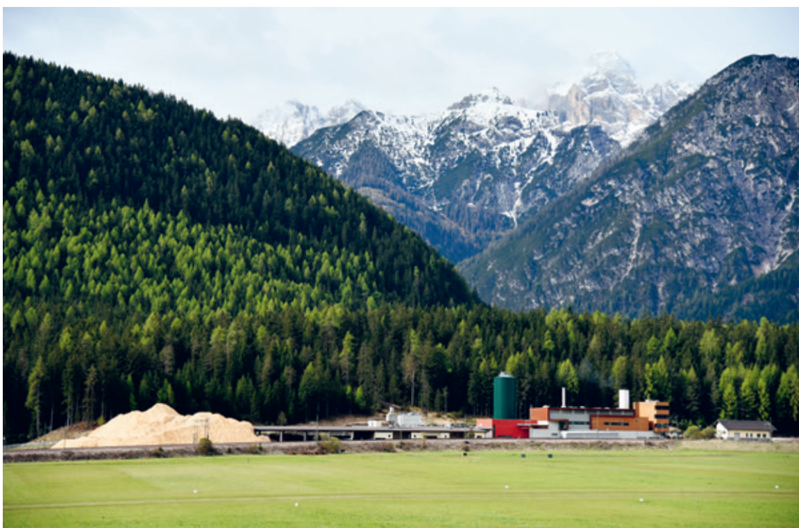
Sempre più cooperative energetiche puntano su fonti energetiche sostenibili per la generazione di elettricità e calore; nell'immagine la Centrale termoelettrica Dobbiaco-San Candido.
